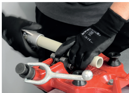
1. Skrapa och fasa röret med avsett kalibreringsverktyg
