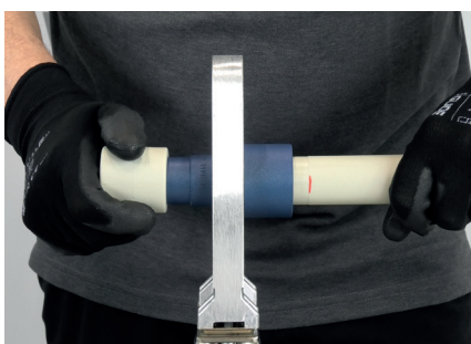
5. Pressa rör och rördel mot svetskopparna
