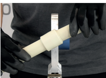
8. I början av kyltiden ska rör och rördel hållas fixerat, för att undvika separation, för fixeringstid se tabell
