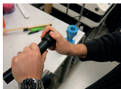
9. Efter att kyltiden har passerats kan belastning ske i form av fortsatt installationsarbete. För full trycksättning krävs att materialet har svalnat till omgivande temperatur
