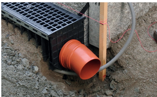
7. Montera ändkåpor i de ändar där det inte sitter ett sandfång. Välj en ändkåpa med utlopp om anslutning önskas i änden på rännan.
