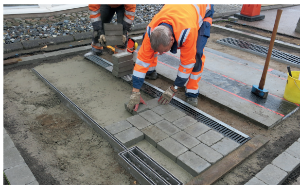
9b. Stenläggning: Gatustenen ska sättas i betong.
