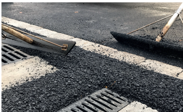
9a. Asfaltering: Att asfaltera direkt emot plastrännan är möjligt, men ska ske med försiktighet.
