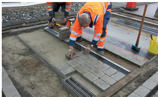
9b. Stenläggning: Gatustenen ska sättas i betong.
