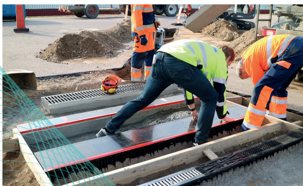
9c. Gjutning: Bygg upp en gjutform och täck över gallret. Mått för er ränna finns på sidorna 6-11.
