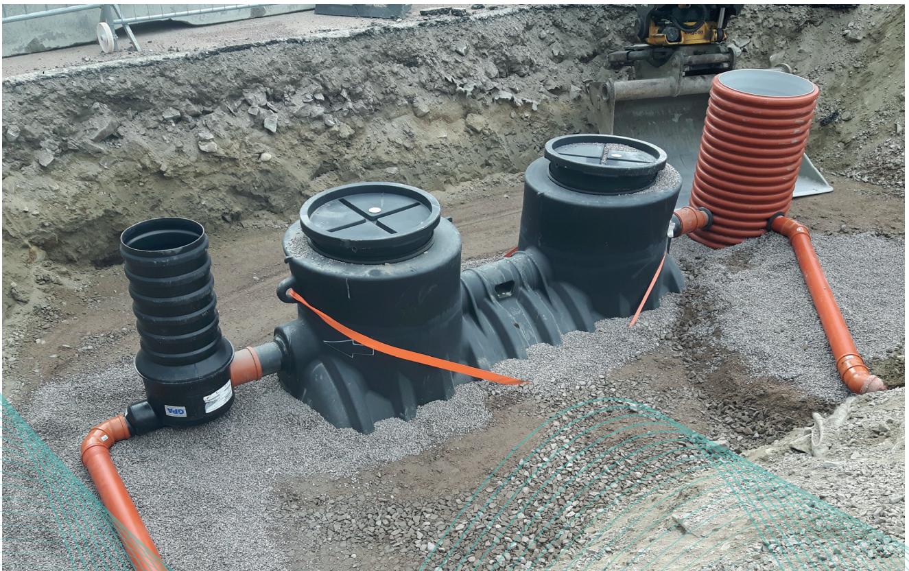
En installation av ett markförlagt avskiljarsystem. GPA förser er med hela systemet från första dimensionering till en färdiginstallerad produkt med alla tillbehör och kringutrustning
