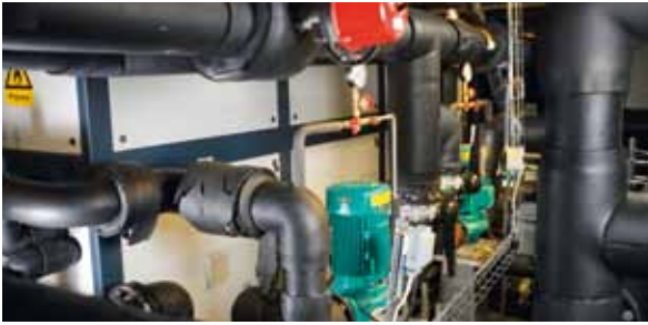
ABS kylrör som isolerats.
